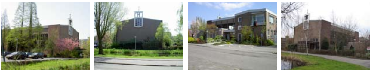
22 Bleulandweg 1 (Gereformeerde Gemeente Synodaal Verband) - Boerhavekwartier
