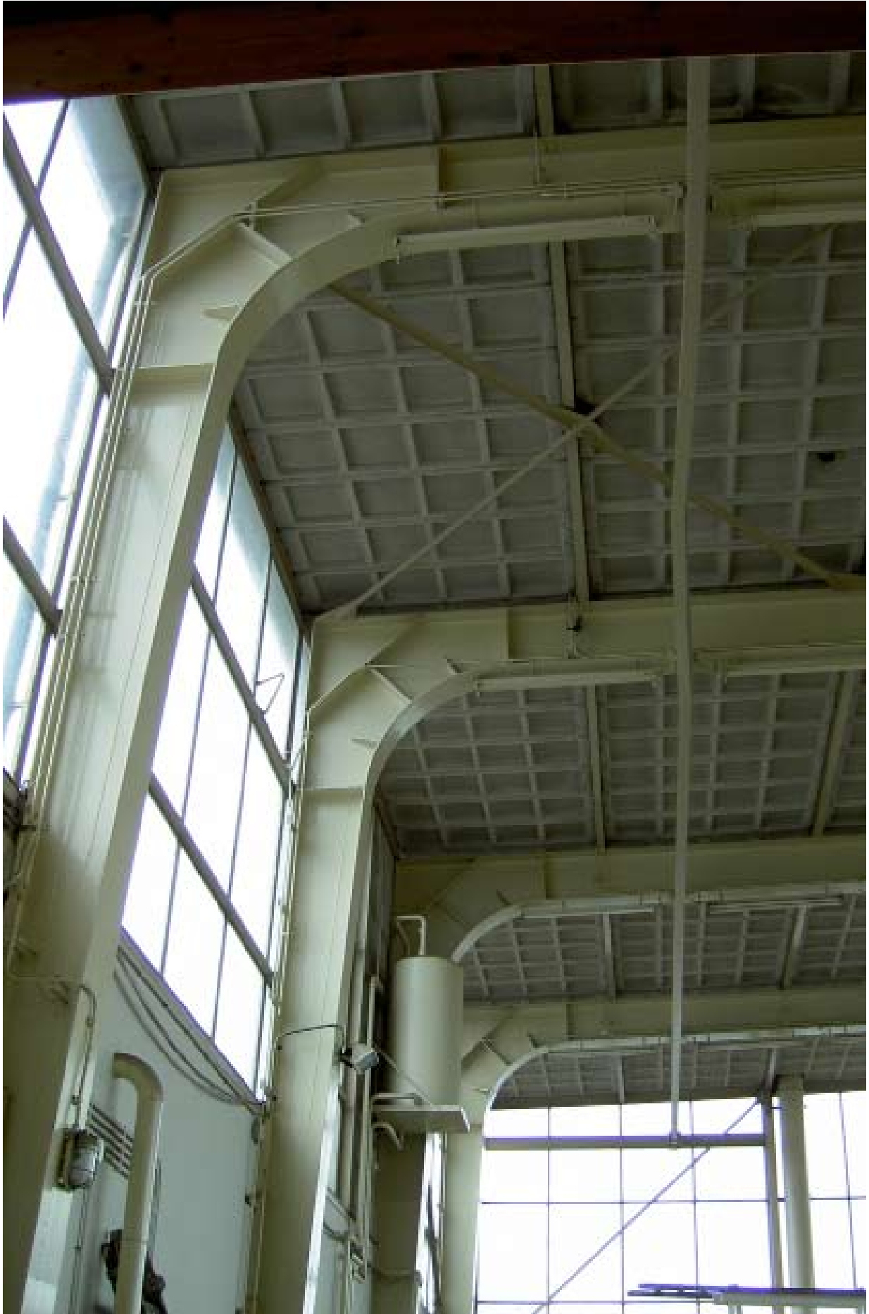
Bedrijfsloods Prevo, Schielands Hoge Zeedijk
